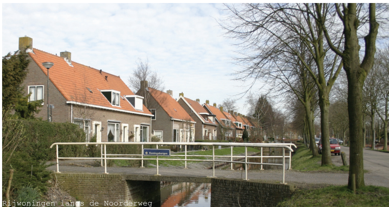
Karakteristieke bebouwing Neck - Ringdijk / Noorderweg
